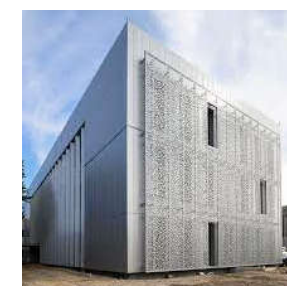
Figure 4 – Bâtiment Miriam MAKEBA
