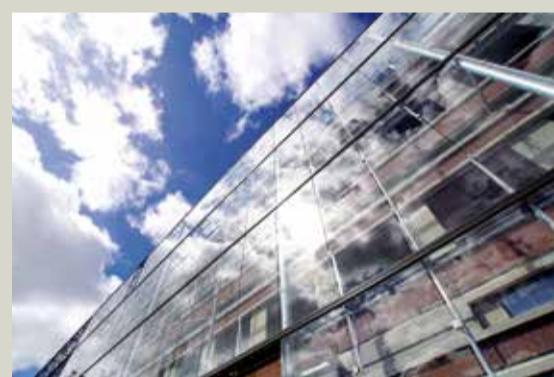
Une isolation thermique pour un meilleur confort intérieur
