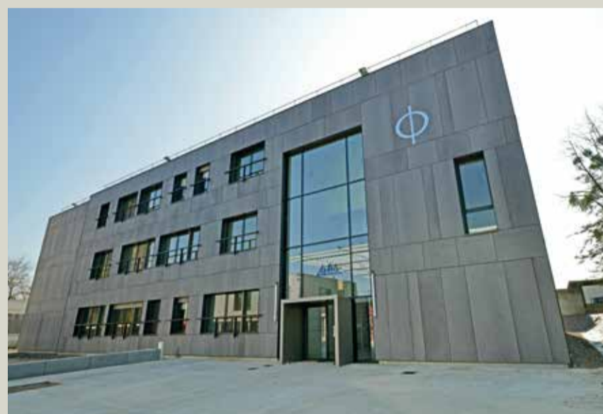
Bâtiment A4 N, sur le campus Talence
